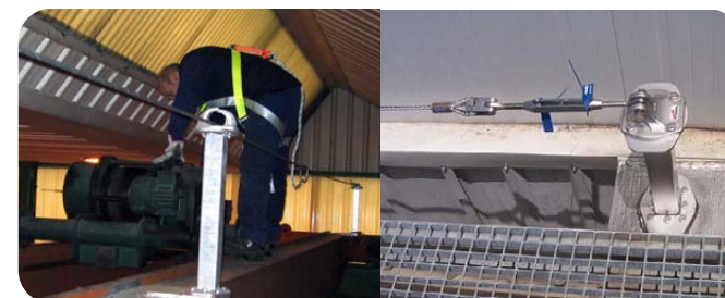
Detalle montaje columna poste sobre puente grúa
