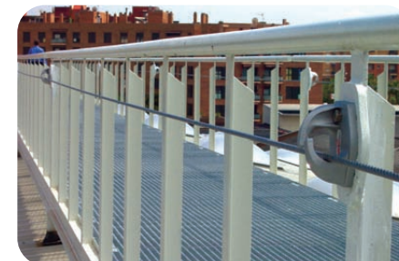
Detalle montaje placas PS14 sobre estructura metálica
