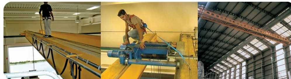
Detalle montaje placas PS14 sobre puente grúa
