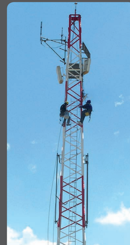
Escalera y línea en torre
