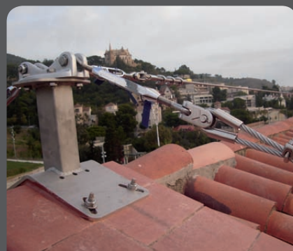
Cubierta de teja
